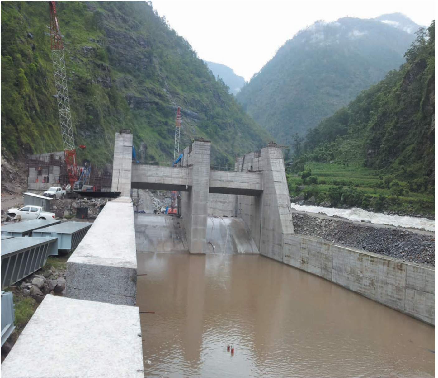
निर्माणाधिन माथिल्लो त्रिशुली थ्रि ए को स्पिल वे निर्माण हुँदै
