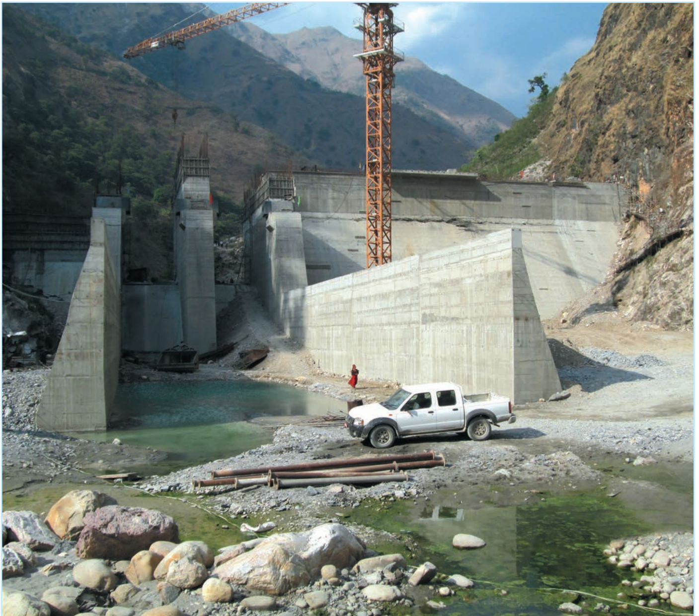
निर्माणाधिन चमेलीया जलविद्युत आयोजनाको स्पिल वे निर्माण कार्य हुँदै
