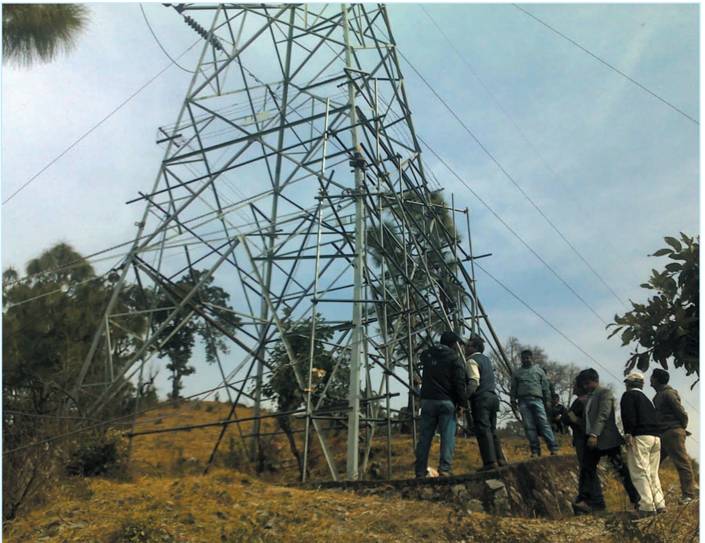
स्यूचाटार-कुलेखानी १३२ के.भि.प्रसारण लाईनको क्षतिग्रस्त टावर मर्मत गरिँदै
